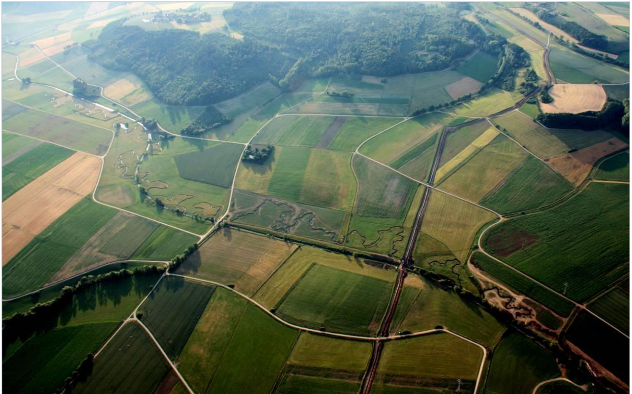
Abb. 2.7.1: Die gut 5 Kilometer lange renaturierte Schneidheimer Sechta im 2,1 Kilometer langen Renaturierungsbereich des 55 Hektar großen Projektgebiets. Rechts der Bildmitte ist schräg von unten nach oben die Trasse der in Bau befindlichen Ethylen-Pipeline Süd zu erkennen. (Foto Vischer)
