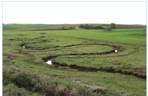
Abb. 2.2.9: Der neue Bach im Rohzustand. (Elser)
