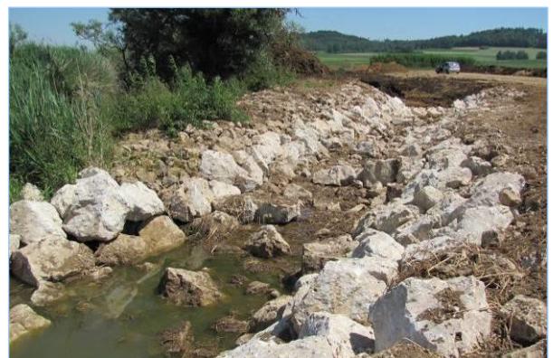
Abb. 2.7.19: Die Sohlrampe am Renaturierungsende (Gefälle ca. 3 %, Höhenunterschied ca. 1 m).
