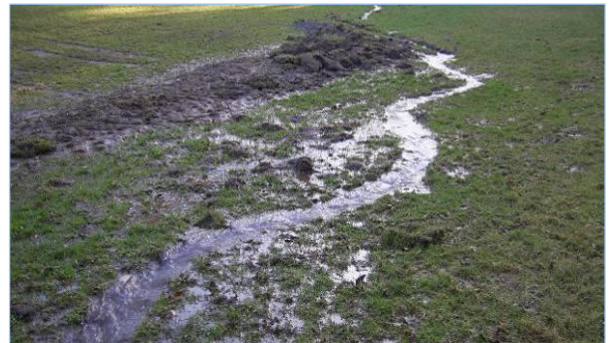
Abb. 2.3.4: Renaturierter Bachlauf, hergestellt mit der Rüttelplatte.
