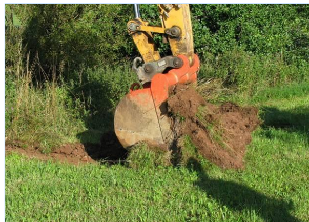
Abb. 2.4.9: Der erste Baggerbiss für die neue Ellenberger Rot. (Foto Elser)
