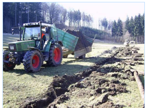
Abb. 2.3.9: Verfüllung des Entrohrungsabschnitts.
