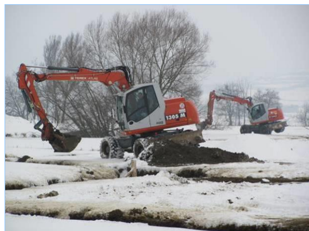
Abb. 2.7.26: Mit dem Bagger wird der Kies eingebracht.
