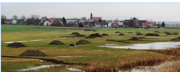
Abb. 2.7.23: Die Kishäufen werden im Abstand von 25 Metern entlang des Bachlaufs geschüttet.
