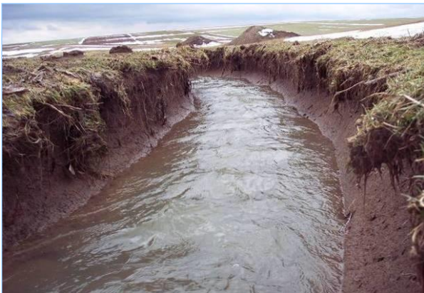
Abb. 2.2.30: An den Ufern erfolgte die Ausbildung einer Hohlkehle. (Foto Elser)
