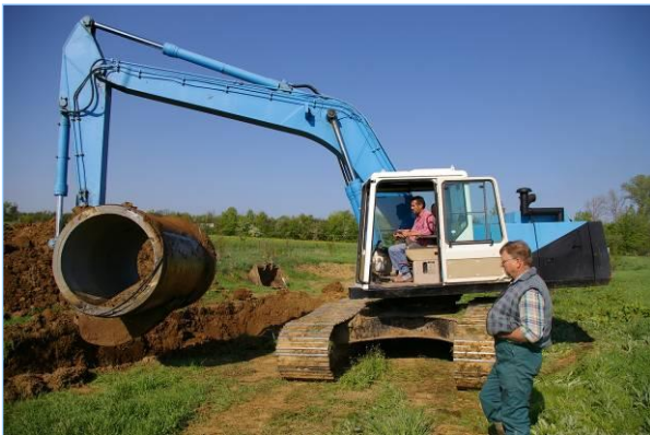
Abb. 2.1.11: Ausbau der Rohre mit dem 27t-Bagger. Ein Rohr wiegt ca. 6 Tonnen und kann vom Bagger gerade noch gehoben werden.
