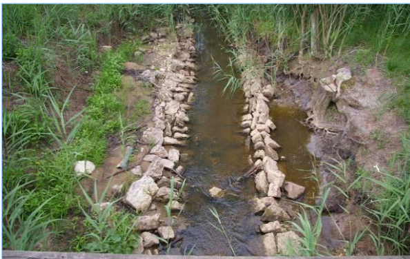
Abb. 2.4.2: Abschnitt der Ellenberger Rot vor der Renaturierung (Renaturierungsbeginn). Der Bach war hier ca. 1,5 Meter tief und in Geländehöhe ca. 7 Meter breit. Die Sohlverbauung ist gut zu erkennen. Links und rechts davon fand, wohl bedingt durch die jährliche Stauseeentleerung, starke Erosion statt.
