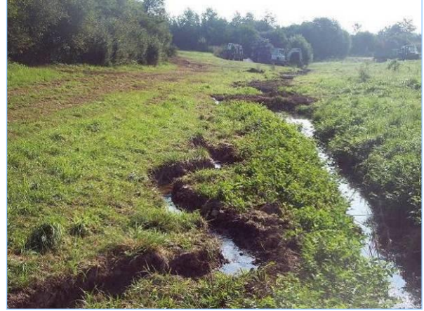
Abb. 2.1.7: Renaturierter und ausgebauter Bachlauf. Der Wasserstand im alten Graben korrespondiert mit dem im neuen Bach.
