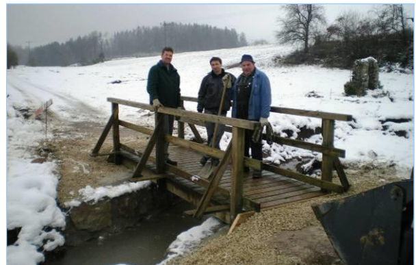
Abb. 2.6.18: Die andernorts abgebaute Holzbrücke nach Montage durch die Mitarbeiter des Wasserverbandsbauhofs. (Foto Gentner)
