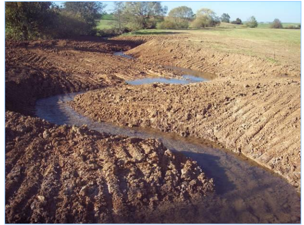
Abb. 2.2.21: Die Umgestaltungsmaßnahme aus Abb. 2.2.20. in der Bauphase: Erheblicher Vorlandabtrag mit modellierten Prall-Gleithängen bei hohem Gefälle. Der bordvolle Abfluss des Gerinnes hat sich gegenüber dem bisherigen Ausbauzustand noch erhöht und Hochwasser kann nicht mehr in die Aue übertreten. (Foto Elser)
