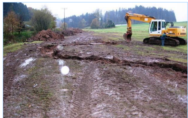
Abb. 2.6.10: Die anhaltend schlechte Witterung erschwerte die Renaturierungsarbeiten durch weichen Untergrund.
