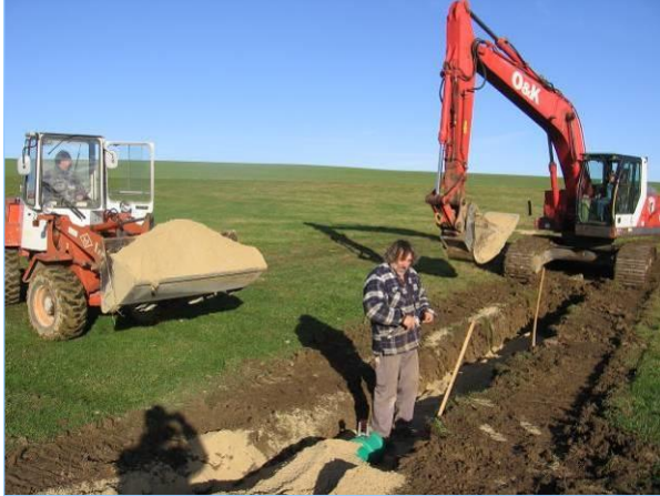
Abb. 2.7.14: Umverlegung der Abwasserleitung.
