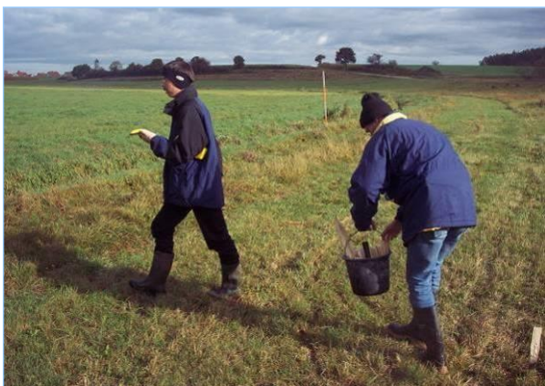
Abb. 2.2.6: Der neue Bachlauf wird, wo nicht mehr erkennbar, mit GPS-Unterstützung eingemessen und mit Holzschindeln markiert. (Foto Elser)
