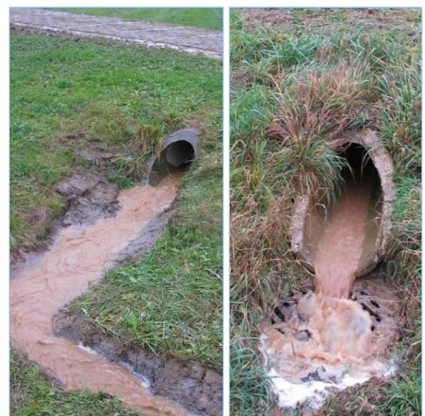
Abb. 2.5.8: ... begraben im Wegdurchlass, wieder auf der anderen Seite, hinabgefahren in die Verrohrung. Er mündet nach 2 Kilometern zur Rechten der Jagst.
