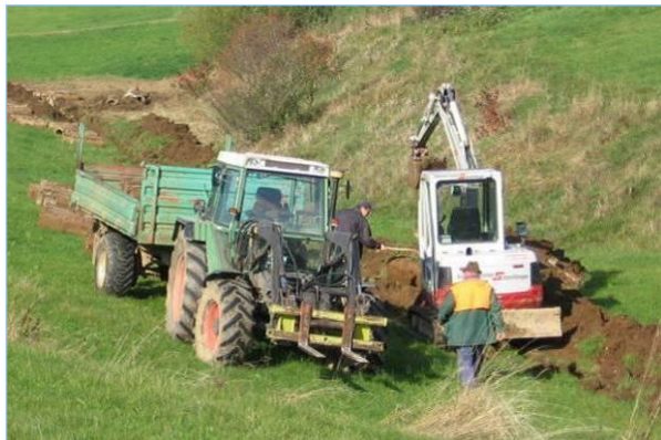
Abb. 2.5.5: Das Bauteam bei der Arbeit.
