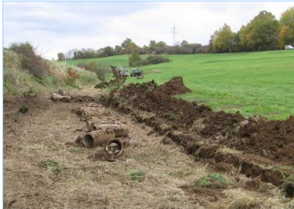
Abb. 2.5.4: Entrohrung des Gangolfsbachs.
