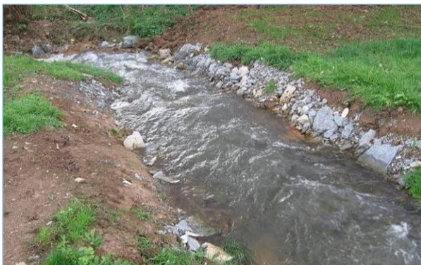
Abb. 2.4.15: Raue Rampe am Renaturierungsende.
