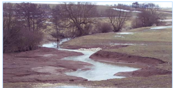
Abb. 1.1.3: Hier wurde die Böschungseinsaat vergessen. Das Hochwasser hat die vom Bagger liebevoll geformten Böschungen weiträumig zerstört. (Foto Elser)
