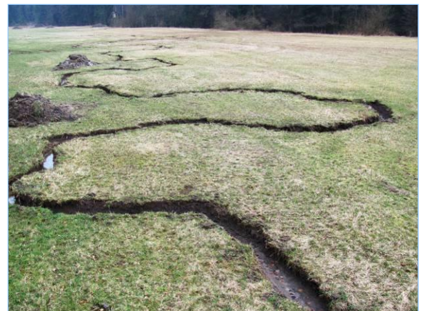
Abb. 2.8.3: Linienführung des renaturierten Glasbachs (Abschnitt mit dem höchsten Windungsgrad). Die Mäander folgen dem Mikrorelief. Der Abschnitt wurde wegen Gefällearmut und Mäanderdimension später auf etwa die doppelte Breite ausgebaut.
