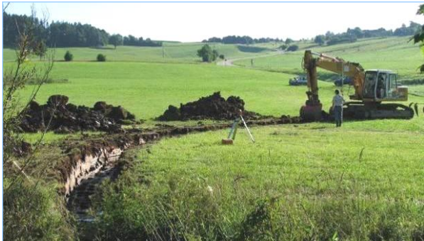
Abb. 2.4.11: Nichts für zarte Naturschutzgemüter: Anlage eines Mäanders im Schilf.
