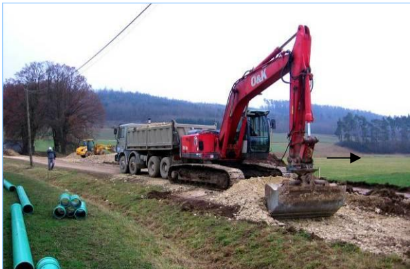
Abb. 2.7.15: Absenkung des Feldwegs um 40 cm. Bei einem großen Hochwasserereignis erfolgt die Überströmung von links nach rechts. Der Pfeil liegt an der Stelle der Sechta im Gelände.
