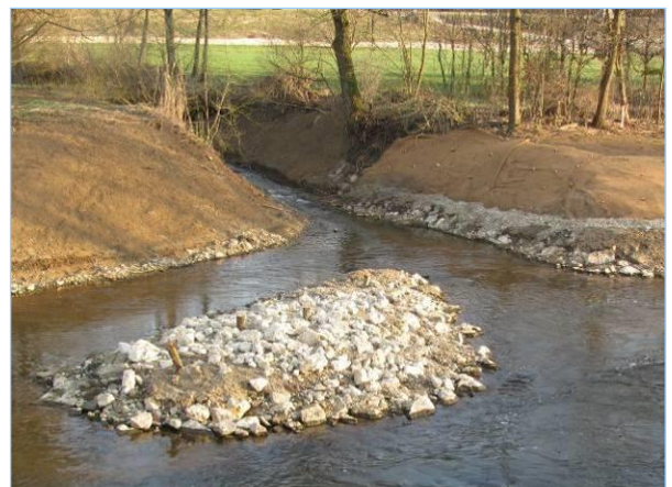
Abb. 1.1.4: Hier wurden die Böschungen mit Jutegewebe gesichert. Eine dekorative Insel aus Kalksteinen wertet das in tonig-sandigem Auelehm verlaufende Gewässer zusätzlich auf.
