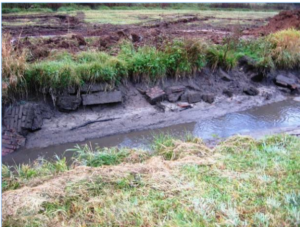
Abb. 2.6.5: Uferbefestigung am ausgebauten Bach. Die aufwändige Entfernung unterblieb, da der Sixenbach ohnehin ein neues Bett erhielt.
