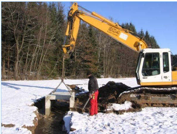
Abb. 2.6.13: Einbau des Hohlkastens in den Bach. Die lichte Weite beträgt 1000 mm auf 800 mm.
