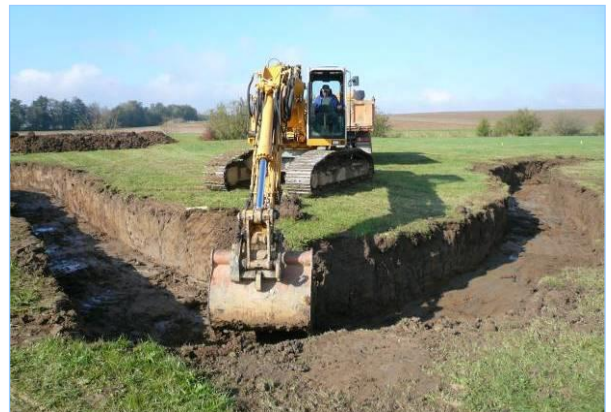
Abb. 2.7.17: Das Rechteckprofil mit den oft kritisierten senkrechten Böschungen. (Foto u. Kritik Engel)
