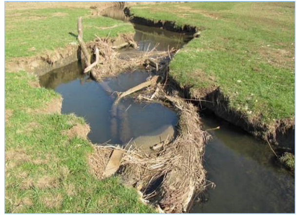
Abb. 2.7.31: „Freilebendes“, mobiles Totholz.
