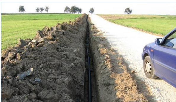
Wegsickerungen (hier im Bau) wirken wie normale Drainagen. (bei Neuler)
