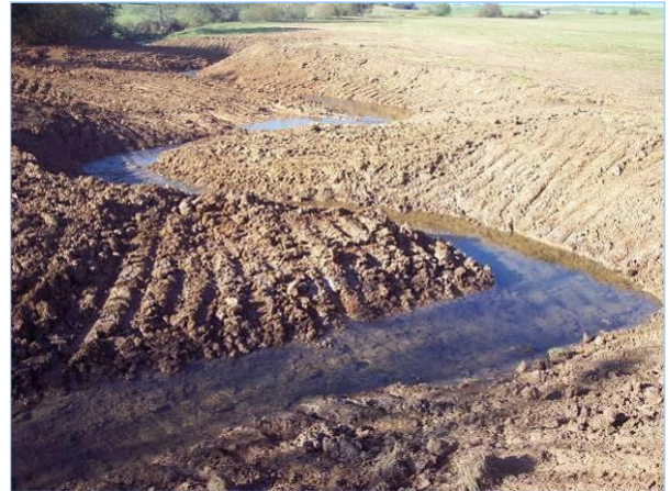
Abb. 1.1.2: Renaturierter Bach mit häufig wechselnden Böschungsneigungen im Prall-Gleithang-look. (Foto Elser)
