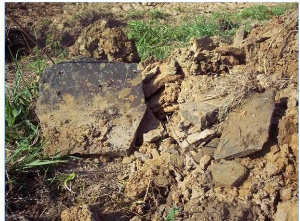
Abb. 2.1.9: Baugrubenaushub aus der gleichen geologischen Schicht wurde von Hand mit dem Schlegel zerschlagen und als Geschiebe eingebaut.
