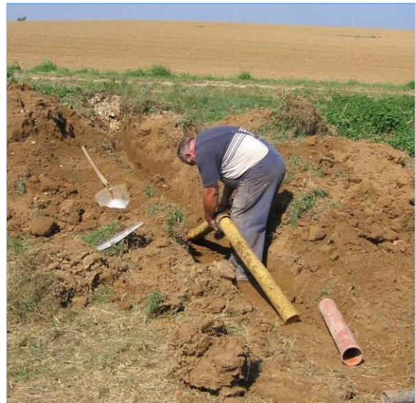
Abb. 3.1.5: Anhebung eines Drainschlauchs. Der Drainagenauslauf erfolgt nun auf der Wiese. (Eichbach)
