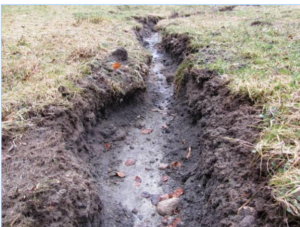
Abb. 2.8.6: Trotz des überwiegend sandigen, leicht erodierbaren Bodens wurde baulich eine gewisse, regellose Breiten-Tiefenvarianz vorgegeben.
