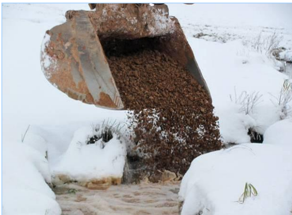
Abb. 2.8.10: Einbringung des Quarzkieses (Korngrößen kleiner 10 cm).
