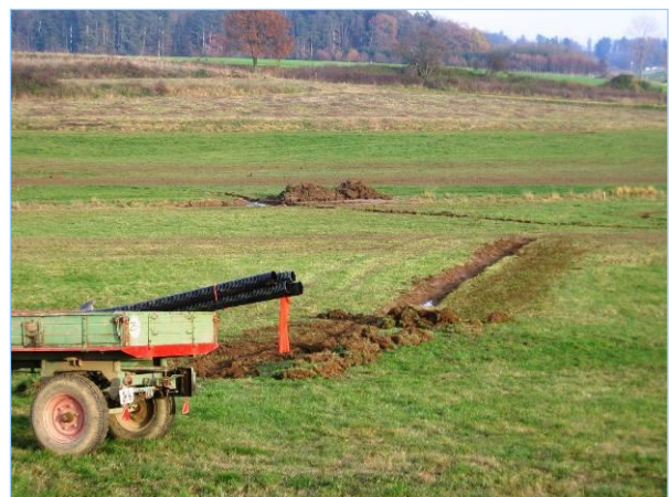
Abb. 3.1.6: Drainstillen mit Drainrohren und Drainschlauchgraben. (Sechta Tannhausen)
