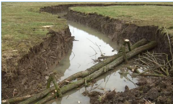
Abb. 2.7.30: Fixiertes Totholz (zum Schutz des Rechens des weit stromabwärts liegenden Hochwasserrückhaltebeckens). (Foto Strauß)
