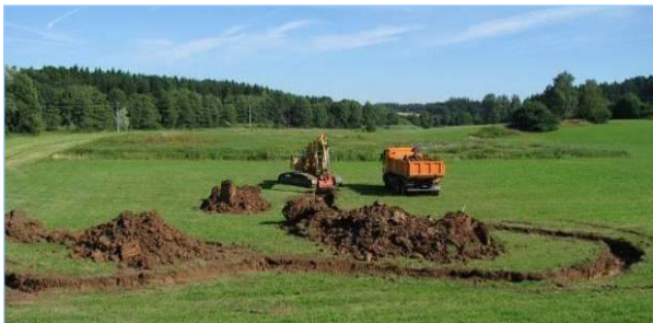
Abb. 2.4.12 bis 2.4.14: Baufortschrittsimpressionen. Das Nivelliergerät (Abb. 2.4.12) war häufig im Einsatz. (Fotos Elser)
