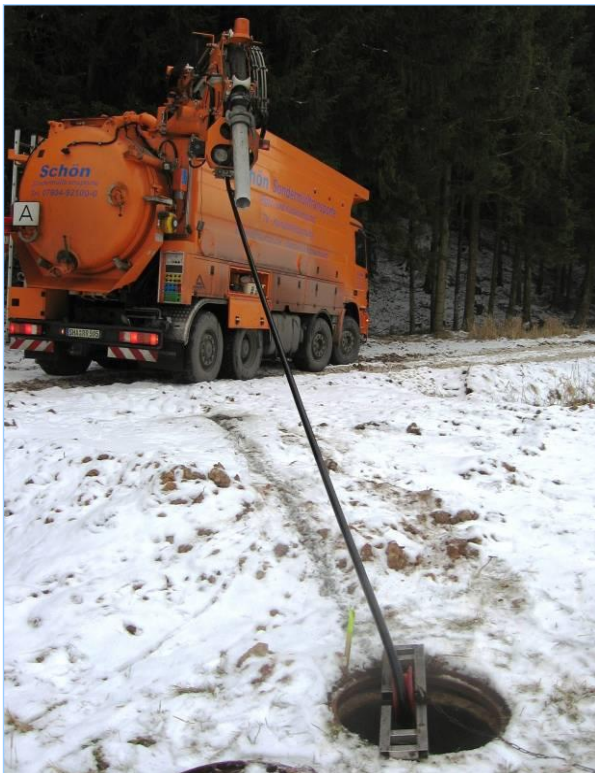
Abb. 2.6.8: Spülung für die Kamerabefahrung der Abwasserleitung (zum Ausschluss von baubedingten Schäden).
