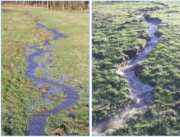
Abb. 2.3.15: Schelmenklingenbach: links: Der Bach sucht sich in einer leichten Mulde selbst seinen Weg. Da im Untergrund mit Bruchmaterial aufgefüllt war, konnte der Lauf nicht mit der Rüttelplatte nachgetieft werden. rechts: nachgegrabenes Bachbett.
