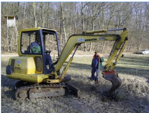
Abb. 2.3.7: Beginn der Bauarbeiten: Ein Minibach wird auch mit dem Minibagger gegraben.
