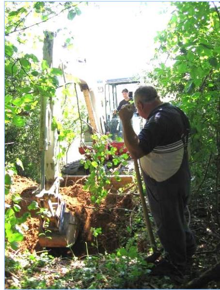
Abb. 3.1.2: Suche nach einer Drainage in einer Hecke. Nach ca. 3 Stunden stellte sich der Erfolg ein. (Eichbach)
