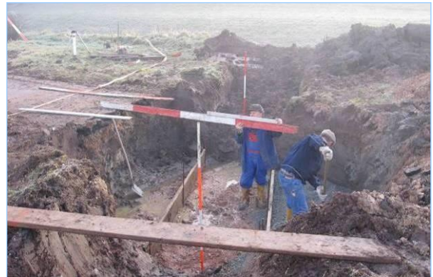
Abb. 2.6.16: ... nach Ausheben des Laufs werden Streifenfundamente betoniert ...
