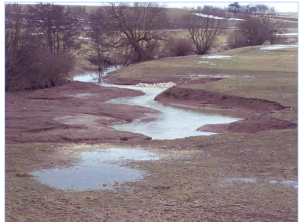
Abb. 2.2.22: Die obige Maßnahme nach dem ersten Hochwasser. Das durch Abtragung mit dem Bagger entstandene Vorland war nicht durch Einsaat gesichert und wurde stark erodiert. Am hintersten Außenhang ist eine Ufersicherung mit Flussbausteinen zu erkennen. (Foto Elser)
