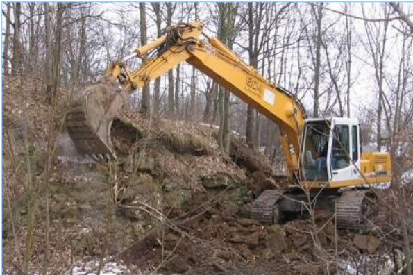
Abb. 2.4.19: Geschiebегewinnung im stillgelegten Steinbruch.
