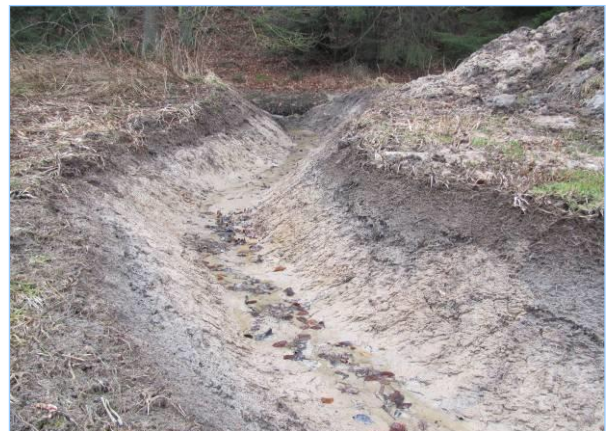
Abb. 2.8.7: Einmündung in den alten Bachlauf. Der Bereich wurde für den Bau einer rauen Sohlrampe mit 1:1-Böschung versehen.
