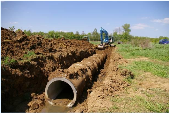
Abb. 2.1.10: Zur Dükerung wird der Eichbach durch diese 1200 mm-Stahlbetonrohre geleitet.
