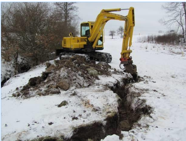
Abb. 2.8.5: Witterungsbedingt kam der Baufortschritt häufig ins Stocken.
