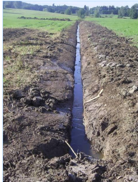
Abb. 2.4.17: Zur Sicherung der Vorflut für ein Privatgrundstück und für das Regenklärbecken wurde entlang der Projektbereichsgrenze dieser Verbindungsgraben angelegt.
