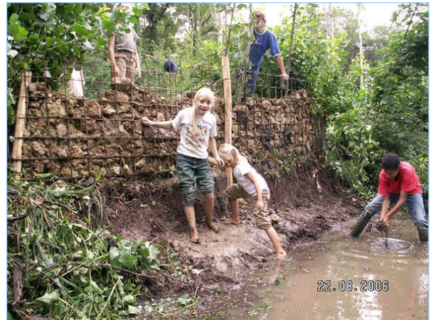
Abb. 1.1.8: Bau einer Eisvogelwand mit Baustahlmatte. Ein solcher Baueinsatz kann auch ideal zur Ausprägung eines geordneten Naturverständnisses bei Kindern und Jugendlichen genutzt werden. (Foto Naturranger-Team Harthausen)
