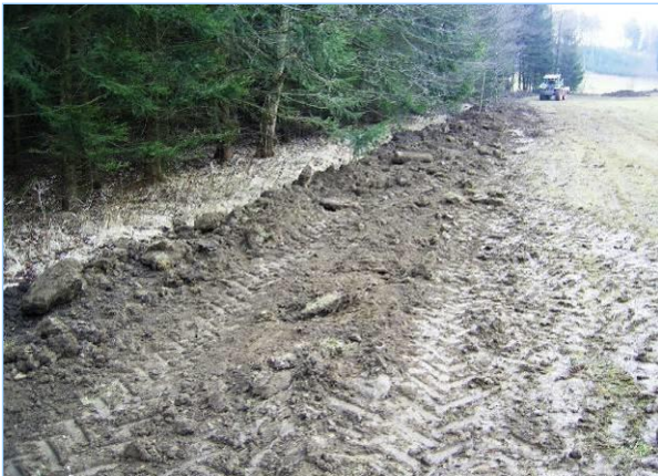
Abb. 2.3.11: Fertig verfüllter Graben.
