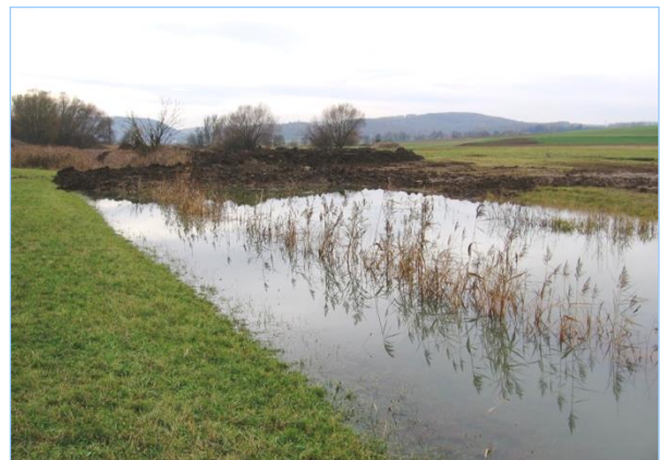
Abb. 1.2.9: 10 Meter breiter Rückstaubereich vor dem Damm. Der Wasserstand am Damm korrespondiert mit dem Wasserstand im renaturierten Bach in Höhe seiner Ausleitung aus dem ausgebauten Bach. Der gezeigte Damm ist von der Ausleitung nach Unterstrom abgerückt. Damit ist der Wasserstand höher als der im renaturierten Bach in Dammhöhe und der Damm ist bei Hochwasser umläufig. (Sechta Bopfingen)
