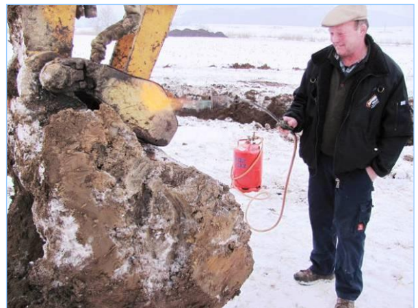
Abb. 2.4.18: Winterliche Nacharbeiten im Vernäsungsgebiet. Bei 10 ° Frost streifte regelmäßig der Schnellwechsler für den Baggerlöffel. Das Auftauen mit Bunsenbrenner funktionierte nicht immer.
