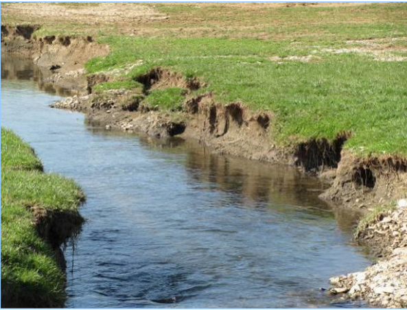
Abb. 2.7.44: Reich gegliederter Böschungsabschnitt.
