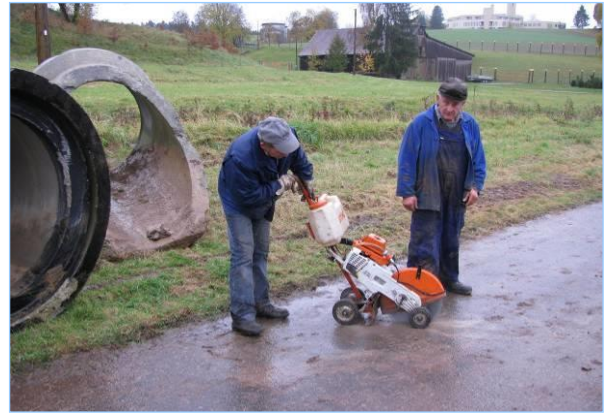
Abb. 2.6.15: Der Lauf des neuen Bachs kreuzt einen Asphaltweg. Die Decke wird durchtrennt ...
