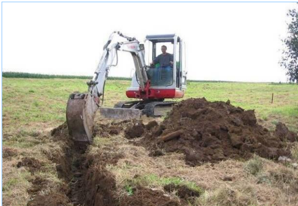
Abb. 2.1.5: Der Baggerfahrer übt noch, nur 20 cm tief zu graben.
