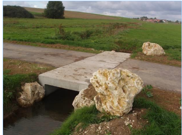
Abb. 2.2.25: Wegquerung des Schlierbachs mittels Amphibientunnel.
