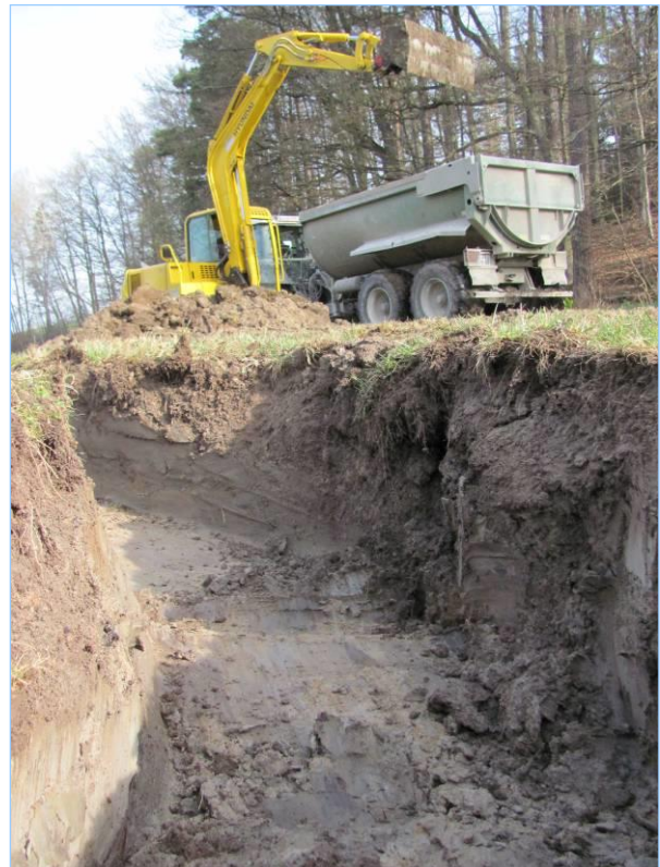
Abb. 2.8.6: Glasbach-Innenansicht im Rohzustand. An dieser gefällearmen Stelle wurde der Bach breiter und tiefer gegraben.
