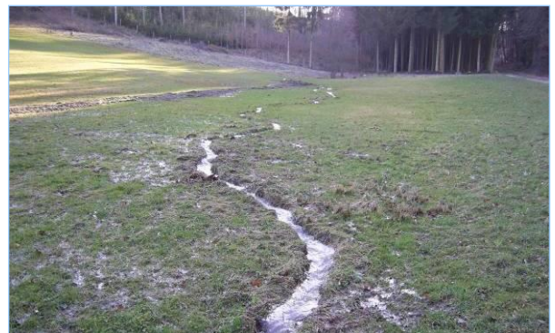
Abb. 2.3.5: Renaturierter Bachlauf, hergestellt mit der gekippten Grabenräumwanne.
