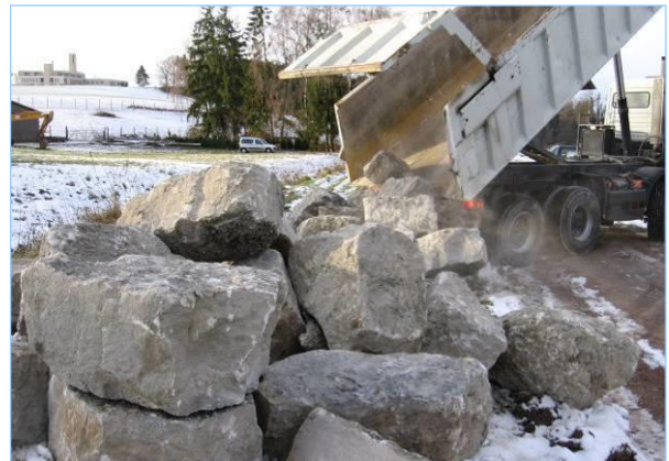
Abb. 2.6.17: ... und Quadersteine werden gesetzt.
