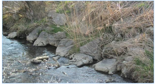
Abb. 2.7.5: Ufer und Sohle der ausgebauten Sechta waren teilweise mit Steinen gesichert.
