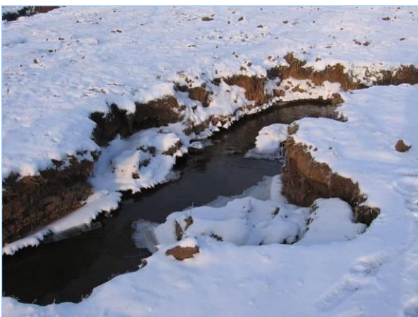
Abb. 2.6.21: Die Uferabbrüche haben z.T. beachtliche Ausmaße. Das Foto entstand kurz nach der Baufertigstellung.
