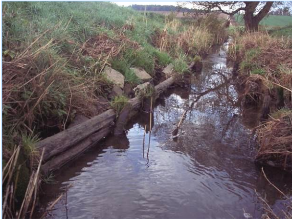
Abb. 2.2.5: Die ausgebaute Sechta in Höhe Schlierbachmündung: mit Holzstangen und Steinen gegen Erosion gesichert. (Foto Elser)
