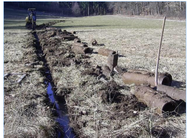
Abb. 2.3.8: Entrohrung des Westteils
