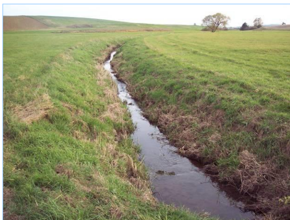
Abb. 2.2.3: Vorher: Die Sechta mit Trapezquerschnitt. (Foto Elser)
