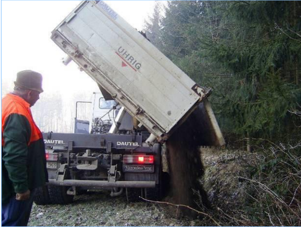
Abb. 2.3.10: Der Graben auf Abb. 2.3.2 wird mit ca. 200 m 3 Erdaushub verfüllt.
