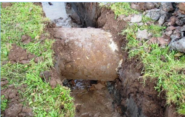
Abb. 3.1.4: Hier wird der Abfangsammler unter der Teichentlastungsleitung durchgeführt. (Glasbach)
