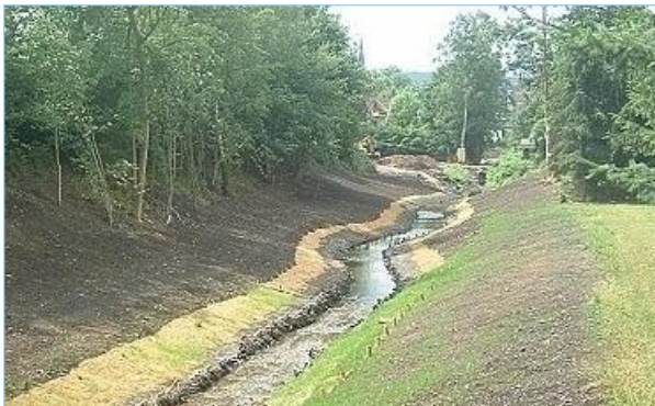
Abb. 1.1.1: Sulzbach: Aufweitung des Bachquerschnitts, leichte Verschwenkung des Bachlaufs sowie Ausbildung von Bachböschungen zur Förderung der natürlichen, heterogenen Fließdynamik. Entwicklung standorttypischer und naturnaher Ufergesellschaften durch Ansaat von Landschaftsrasen und Pflanzung von Uferstauden. (Foto und Text Stadt Saarbrücken)
