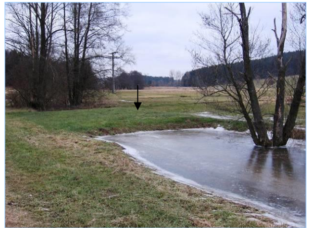
Abb. 2.4.28: Der eingesäte Damm im alten Lauf fällt kaum auf. Im Anschluss entstand ein fast bordvolles Stillgewässer.
