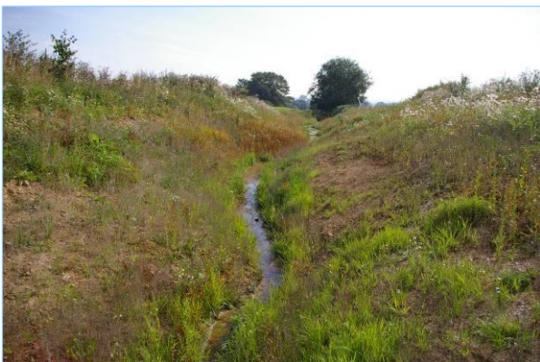
Abb. 2.1.12: Der nicht renaturierbare, aber entrohrte Abschnitt des Eichbachs. Die „Schlucht“ entstand wegen der großen Rohrüberdeckung.
