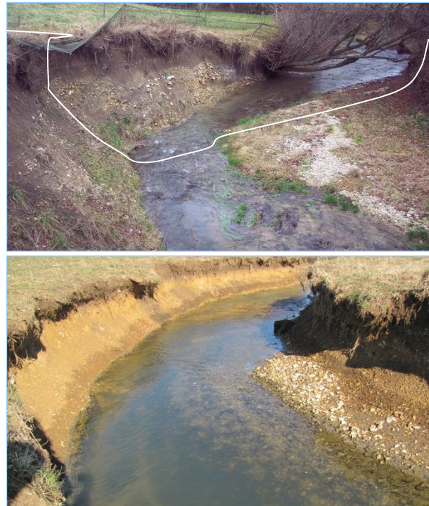
Abb. 1.2.3: Oben: Naturnaher Abschnitt der Rems bei Essingen: Der Prallhang ist durchgehend steil mit oben senkrechtem Abschnitt und überhängender Vegetation/Hohlkehle. Für den oberen Teil des Gleithangs gilt dasselbe (Foto Elser). Unten: Mit Rechteckquerschnitt gegrabener Abschnitt der renaturierten Sechta 9 Monate nach der Flutung.
