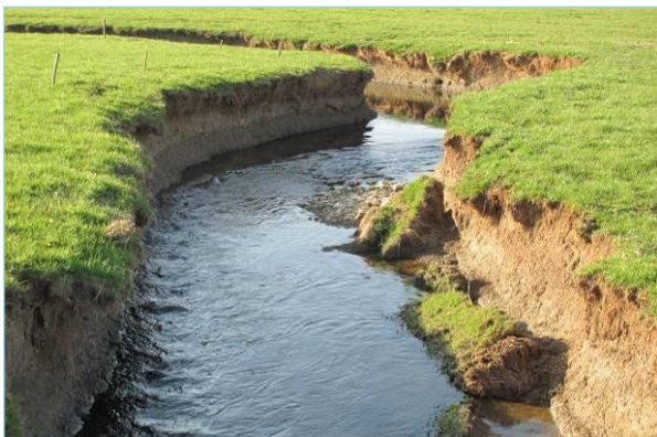
Abb. 2.7.40.: Dort wo Grünland die Ufer fixiert, entsteht unter der Grasnarbe eine Hohlkehle. Mit der Zeit brechen die überhängenden Bereiche in Form von Schollen ab.
