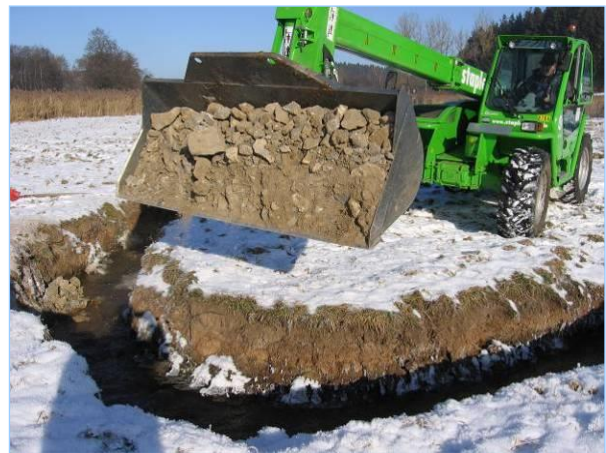
Abb. 2.4.22: Das Geschiebe wird mit dem Teleskoplader in den Bach eingebracht.
