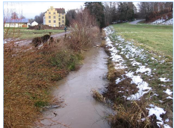
Abb. 2.6.2: Der ausgebaute Sixenbach (unterer Abschnitt) bei Hochwasser. Im Hintergrund das ehemalige Domizil der Comboni-Missionare.
