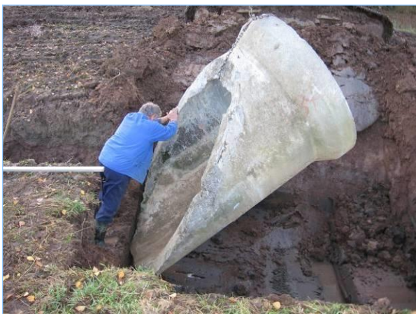
Abb. 2.6.14: Im Bereich eines kleinen Hochwasserdamms war genügend Höhe für den Einbau eines 1.200 mm-Stahlbetonrohres vorhanden, ein „Recyclingprodukt“ von der Eichbach-Renaturierung.
