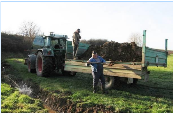
Abb. 2.2.13: Geschiebeeinbau von Hand.
