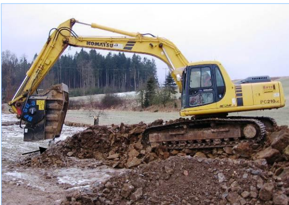
Abb. 2.4.21: Brechen der Steine mit dem Baggerbrecher. Der Pfeil zeigt auf das aus dem Brecherkorb herausfallende, gebrochene Material.
