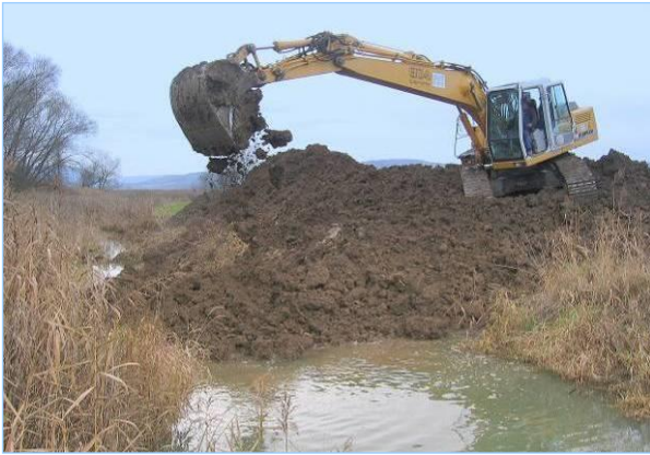
Abb. 2.7.20: Der Lauf der alten Sechta wird durch 13 mächtige Dämme unterbrochen.
