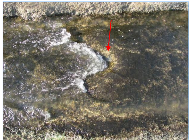
Abb. 3.2.5: In der renaturierten Sechta haben sich am Ende des 1. Bauabschnitts nach 2 Hochwasserereignissen Stufen in der tonigen Sohle gebildet (Pfeil), die durch Erosion in Folge der gegenüber dem Naturzustand überhöhten Fließgeschwindigkeit verursacht wurden. Mittlerweile ist auch der 2. Bauabschnitt fertig gestellt und im gezeigten Bereich hat sich die Fließgeschwindigkeit deutlich reduziert.
