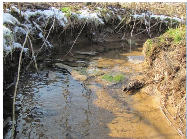
Abb. 2.1.20: Insbesondere in den Kurven sind Aufweitungen, bis (wie hier) zum Doppelten der gegrabenen Breite (60 cm), zu beobachten. Auch Eintiefungen von ursprünglich 0,2 m auf 0,35 m sind vorhanden.
