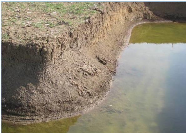
Abb. 2.7.39: Durch den winterlichen Frostwechsel bröckelt die Böschung ab und es entsteht am Böschungsfuß eine Schräge mit einem Schüttwinkel von ca. 45°.
