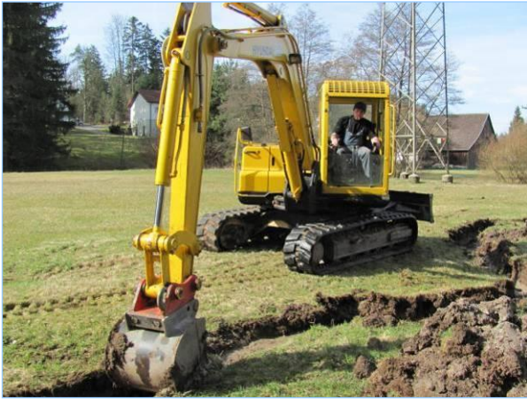
Abb. 2.8.4: Bauarbeiten am Glasbach. Der 8 Tonnen-Bagger erwies sich für Arbeiten dieser Größenordnung als optimal.
