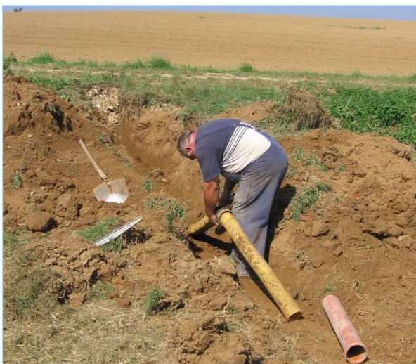
Abb. 2.1.6: Nach langer Suche konnten die gefundenen Drainagen höher gelegt werden, um sie zur „Vorklärung“ in der Wiese auslaufen zu lassen.
